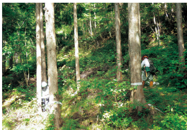
ワイリーテープ施工中
