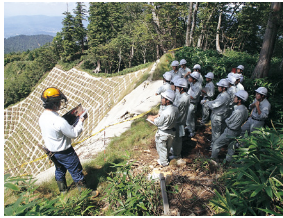
姥ナギ沢復旧治山工事施工地上部より見学
