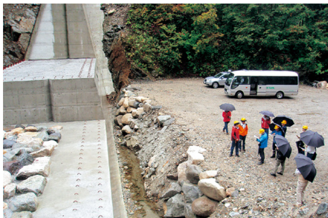
溪間工の説明状況（本年度は2年目で作業は終了）
