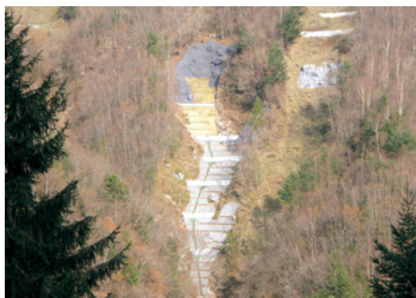
山腹工施工地（割沢）
