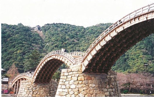
架け替え工事が終了した錦帯橋
