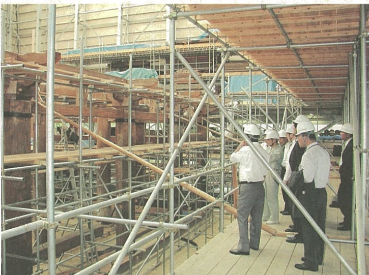
唐招提寺・金堂の解体修理の状況
