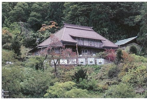
アンカー工により保全された民家(財又(別府))
