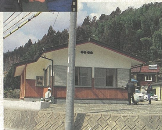
竣工した神坂森林事務所
