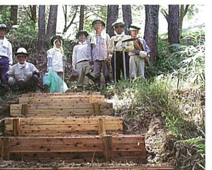
散策路の整備で木製階段を設置
