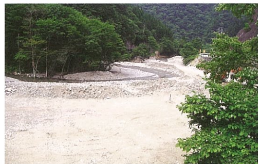
流出した土砂が堆積した板取川の溪流
