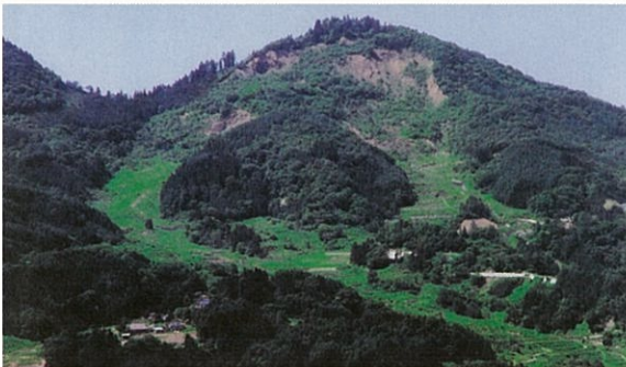
和奈出沢地すべり復旧の状況（昭和59年）
