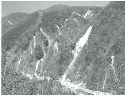
三右衛門沢の崩壊地と施工箇所
