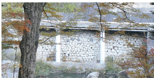
現存する旧国道下に残る石垣（木曾の棧）
