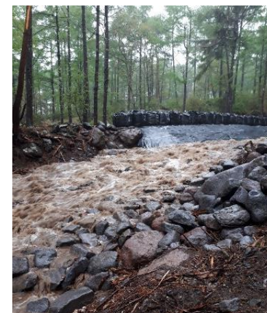
緊急工事の施工効果
