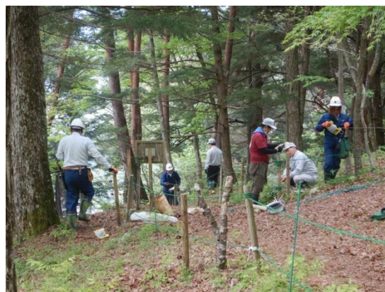
電気柵の設置作業
