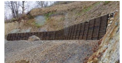
木製校倉式土留工を実施した山腹工 （麦島復旧治山工事）
