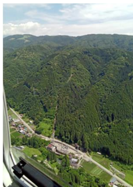
高山市丹生川町民有林 新生崩壊地等は確認され ませんでした。
