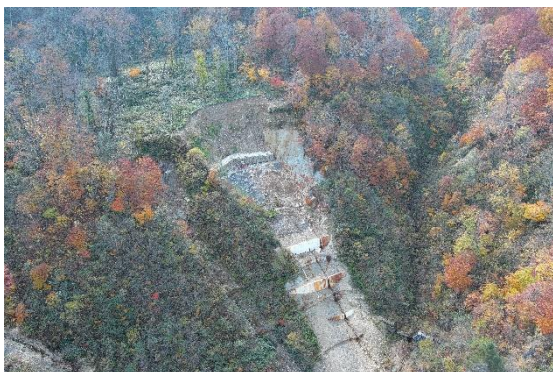
山腹工の施工事例 (白川村 大白川国有林)
