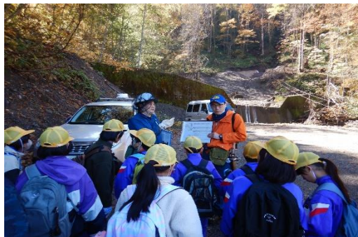
栃尾小学校による森林教室（治山工事見学）
