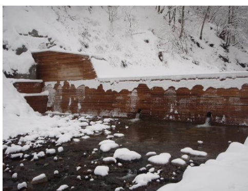
溪間工の施工事例 (高山市 福地国有林)
