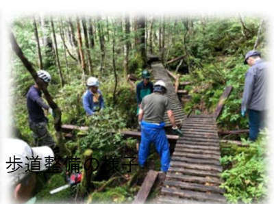
歩道整備の様子
