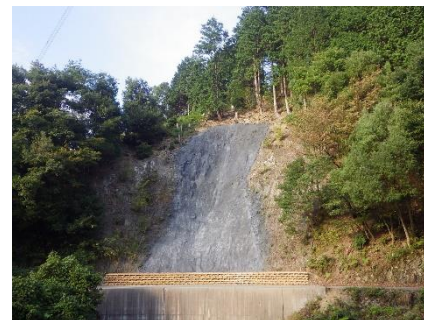
林道の山留に採用した丸太土留工
