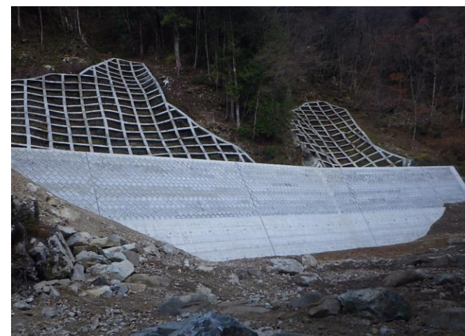
林道災害復旧工事 (落合国有林)
