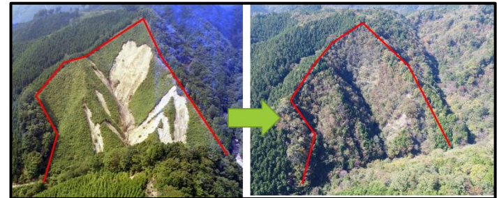
白井沢支流の災害発生時と復旧後 20 年経過した状況
