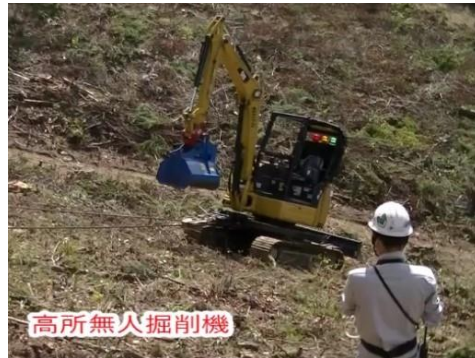
高所無人掘削機（リモコンで操作）
