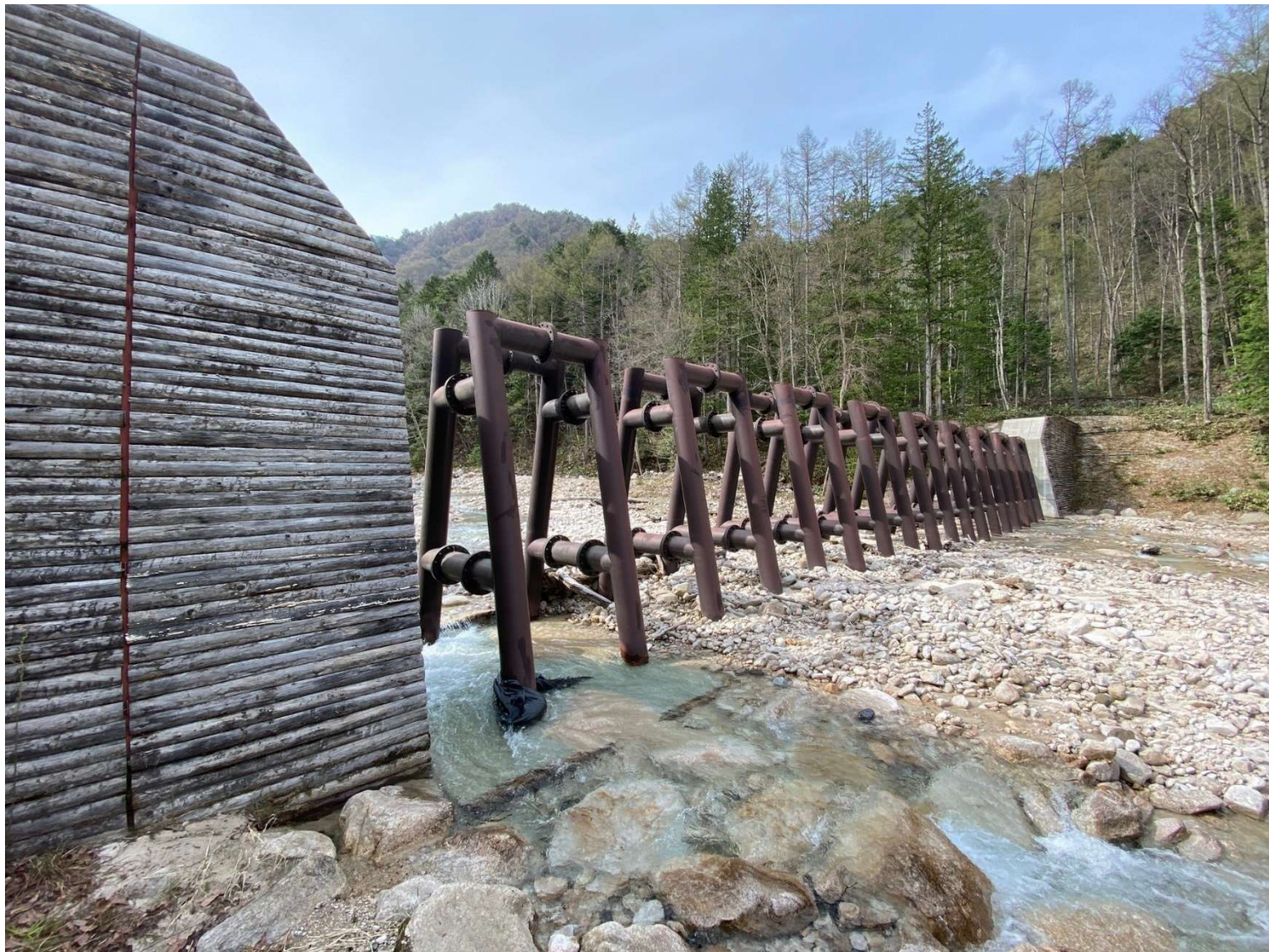
芦間川第1号鋼製スリット谷止工(松川村馬羅尾)
