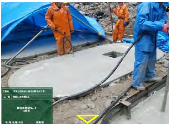
基礎部コンクリート打設
