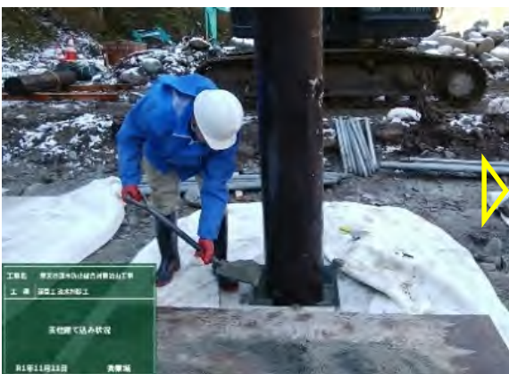
上部構造（柱用鋼管：鋼製スリット部） の設置
