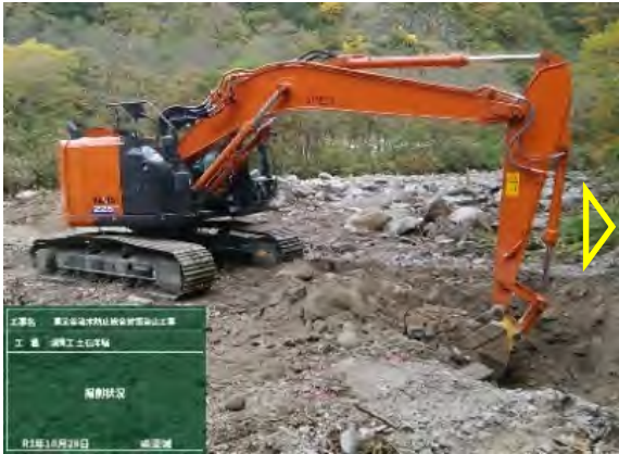
下部構造（基礎部）の掘削
