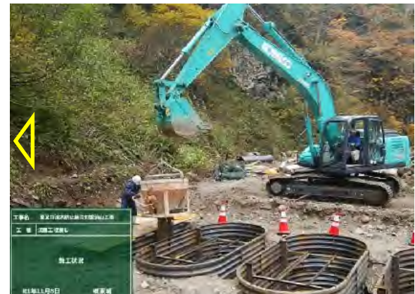
下部構造（基礎部）の埋戻し
