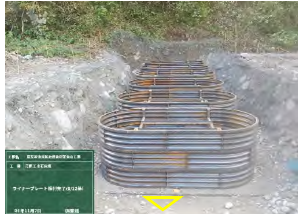
下部構造（基礎部）の設置
