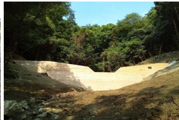
復旧治山工事（残存型柵）
