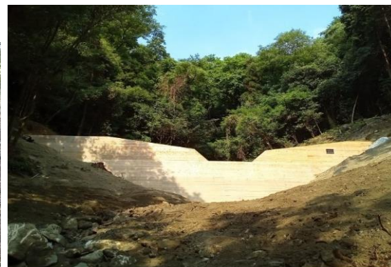
復旧治山工事（残存型枠）
